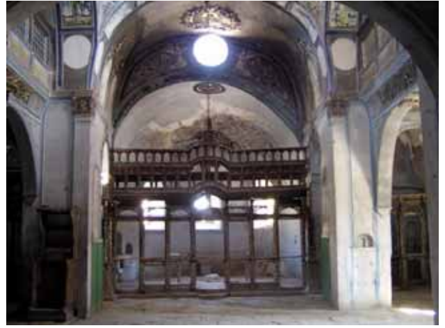
Sille. Aya-Elena Kilisesi. Apsis'i perdeleyen ahşap yapı hala ayakta.
